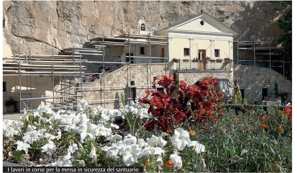
I lavori in corso per la messa in sicurezza del santuario
